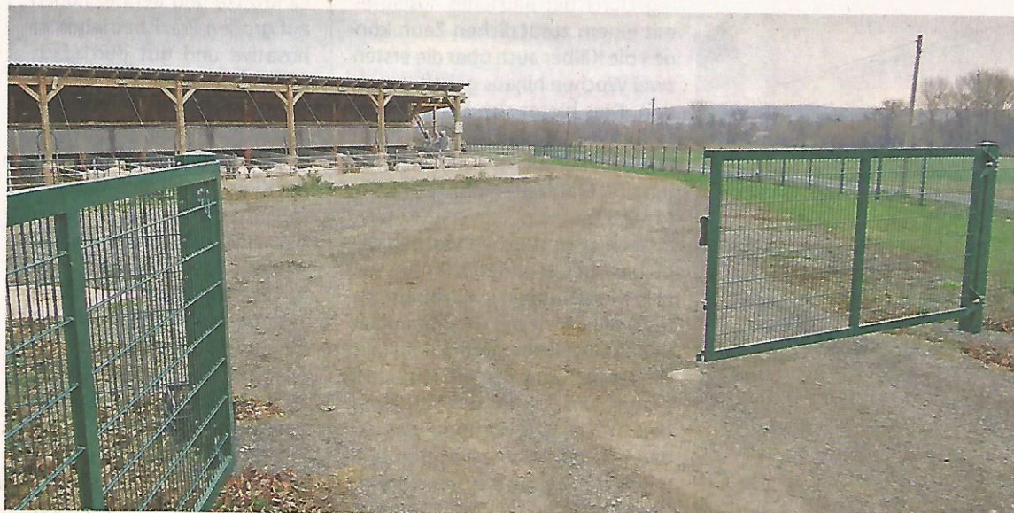
Auslaufhaltungen von Schweinen können mit einem stabilen Zaun mit Unterwühlenschutz um das Betriebsgelände sicher gegen den Eintrag der ASP geschützt werden. Foto: Christian Wucherpfennig
